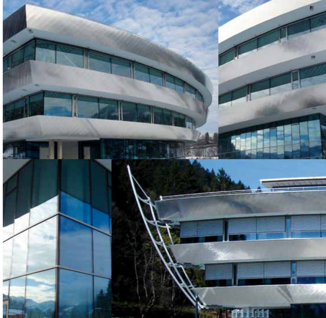
In Zusammenarbeit mit der Fa. Steindl Glas führte Alois Muigg im Frühjahr/Sommer 2008 die Alu-Glas-Fassaden / Metallbauarbeiten für die Europazentrale der Fa. Eurotours in Kitzbühel aus
