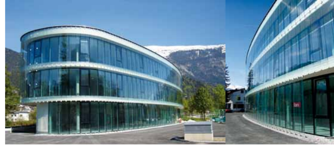
Ebenfalls 2008 wurde Alois Muigg von der Fa. Realbau für das Geschäftshaus „Business + More“ in Schwaz mit den Fassadenkonstruktionen (Alu-Glasbau, vorgesetzter Glasschirm), den Brandschutzportalen (Alu und Glas) sowie mit den Schlosserarbeiten (Liftschächte in Stahl und Glas, Geländer in Stahl und Glas, div. Schlosserarbeiten) beauftragt.
