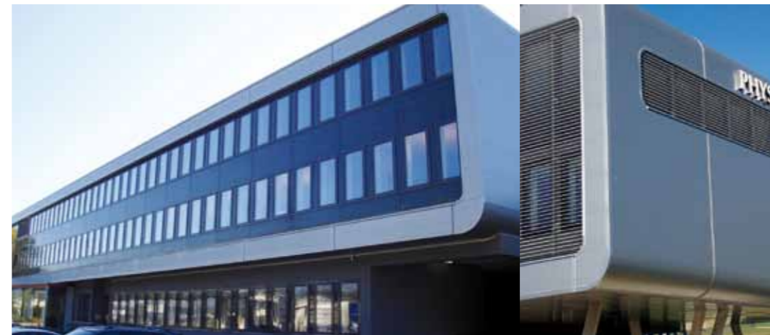
Für Phyiotherm in Hall wurden Alois Muigg 2008 für die Fassade sowie Fenster und Türen in Alu beauftragt. Es wurden hochwärmege-dämmte Aluprofile und Verglasungen zur Erreichung entsprechend niedriger U-Werte verarbeitet.
