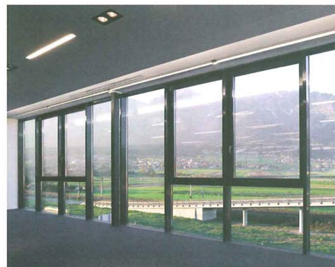
Der „Adlerhorst“, Fassade Hueck/Hartmann VF50RR
