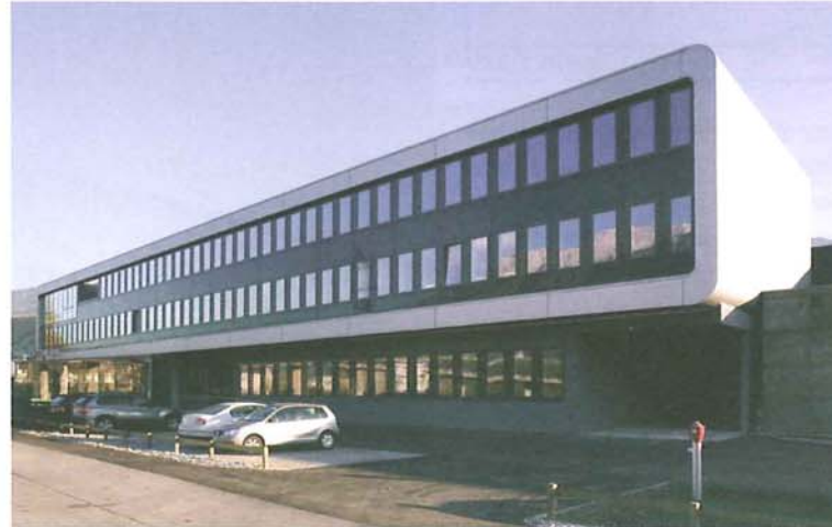
Fenster: Einselemente Hueck/Hartmann Systherm 72 E
